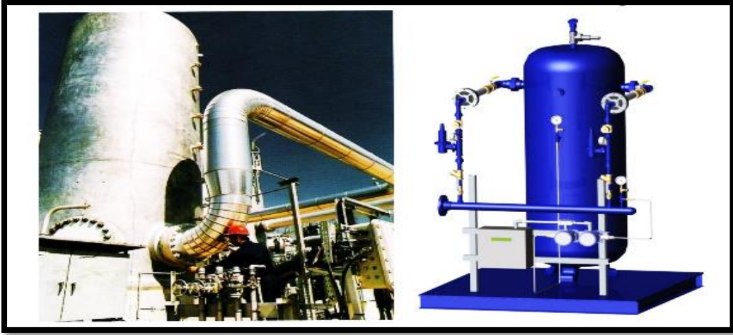
الشكل (1-1) يبين خزان الهواء المضغوط
